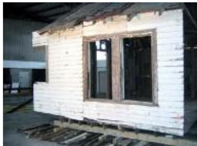
Haus 24620 - von Detroit nach Halle-Neustadt
